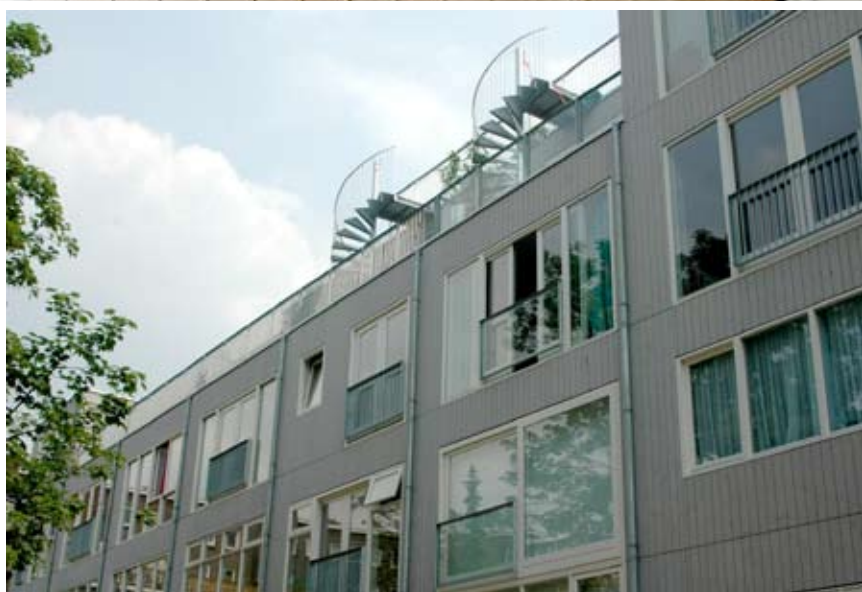
Het Wallisblok na de renovatie.
